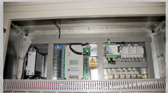
Rys. 4. Widok przedziału średniego napięcia rozdzielnicy ST – 7,2.
