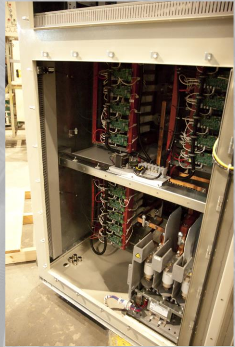
Rys. 4. Widok przedziału średniego napięcia rozdzielnicy ST – 7,2.
